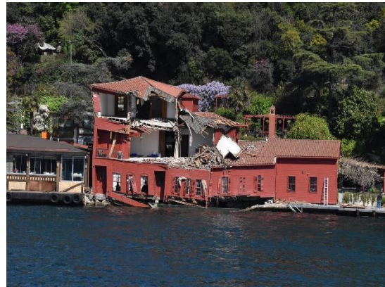
貨物船が壊したらしい建物です。
