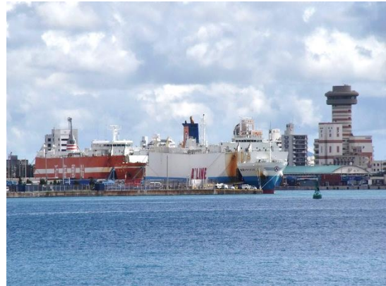
安謝港(那覇新港)には、RORO 貨物船「琉球エクスプレスⅡ」と「しゅり」が停泊していました。那覇港からは九州、関西、関東への高速 RORO 船網が整備されており、南からのコンテナ船のトランシップハブとなれば、沖縄だけでなく、日本本土へのコンテナ物流には大きなメリットになりそうです。
