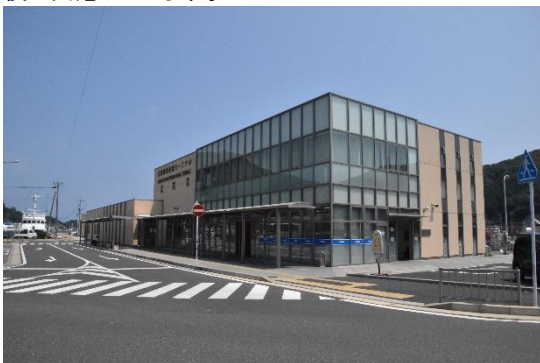
比田勝港の国際船用のターミナル。
