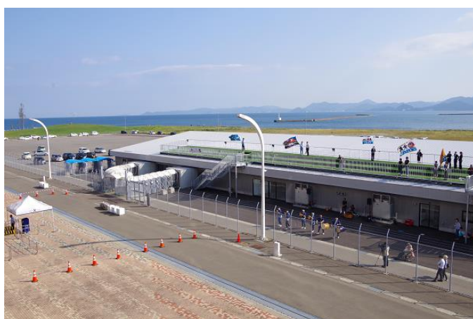
入港歓迎してくれた青森港新中央埠頭客船ターミナル
