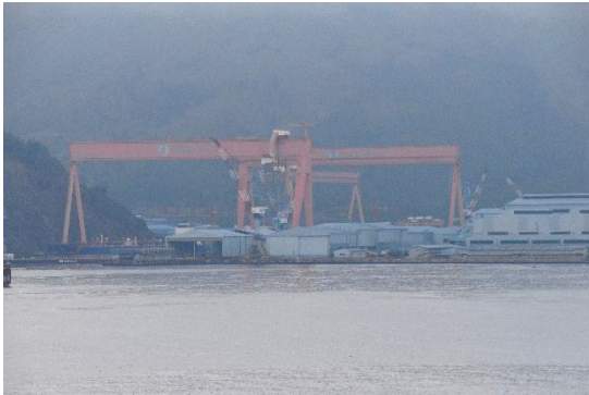
スービック湾に入ると造船所のガントリークレーンが見えました。こんな大きな造船所があるとは知りませんでした。
