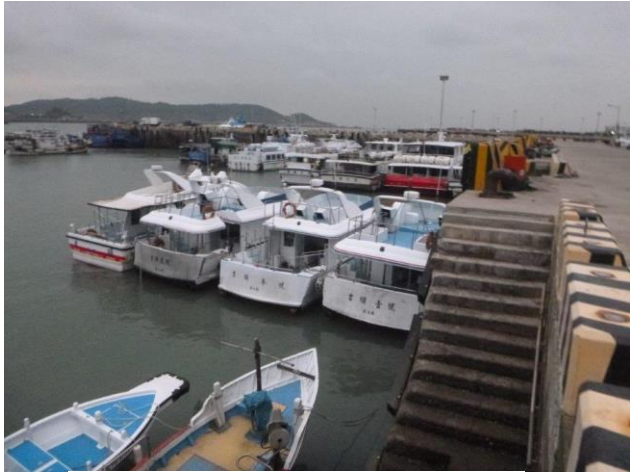
福澳港の高速船艇船溜まり（干潮時）
