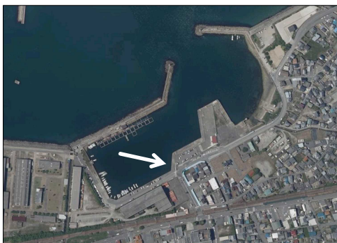
【深日港】深日港3号岸壁
