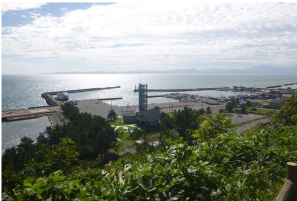
蟹田港全景（中央のタワーがターミナルで、左が乗り場）
