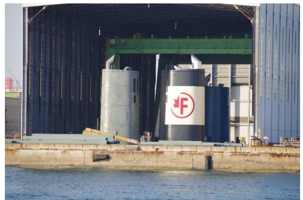
煙突製作中 中に7~8基、屋外にも3~4基
