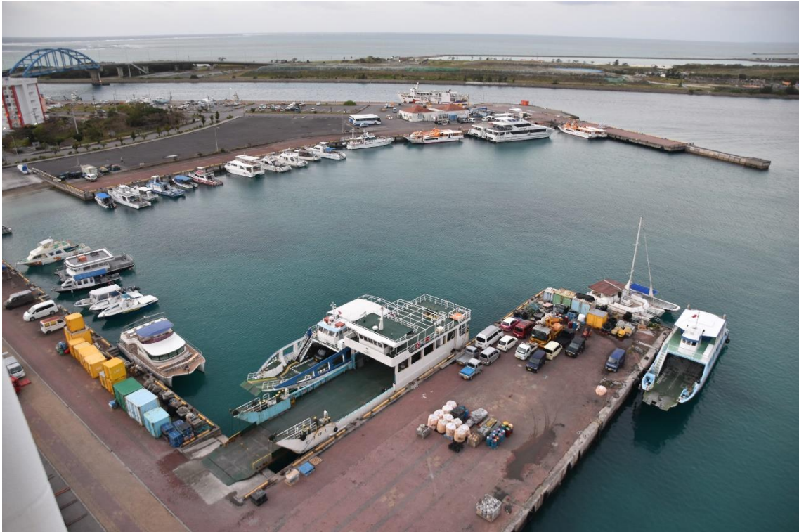
石垣港の南側の船だまりで、手前が RORO 貨物船の埠頭になっており、主にダイビングボートが繋がれています。奥の一面には石垣ドリーム観光の船の係留場所が見え、その奥が波照間島の在来船の埠頭です。与那国島へのフェリーもここから出ます。
