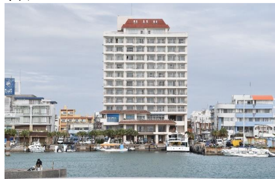
石垣港に面してたつ「ホテルイーストチャイナシー」です。全室、港に面しており、ベランダもついています。
