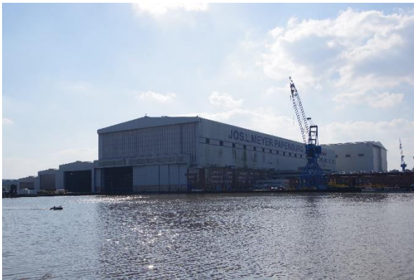
東側から見たドック 1
