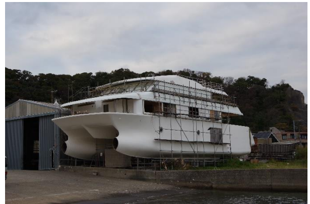
久里浜港内オリエンタルボートで建造中の 26m 双胴船
