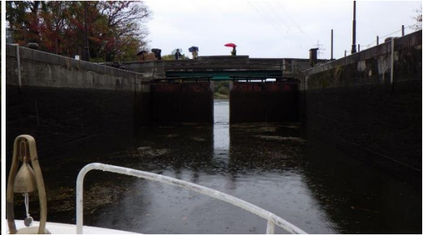
排水が終わりゲートが開いた（高さ 2.5m 程変化）
