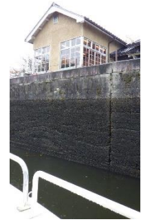
中島閘門操作室
