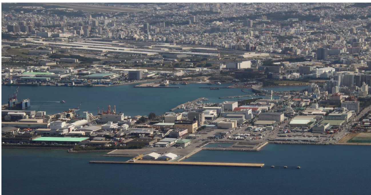
那覇新港の新しいクルーズ船岸壁。
