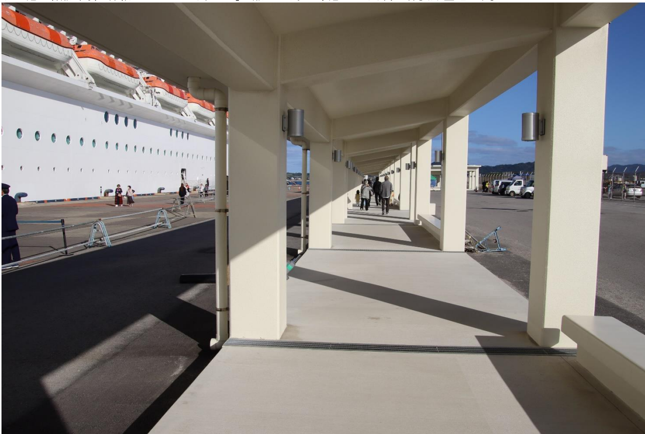
クルーズ岸壁にはコンクリートの通路が設置されていました。
