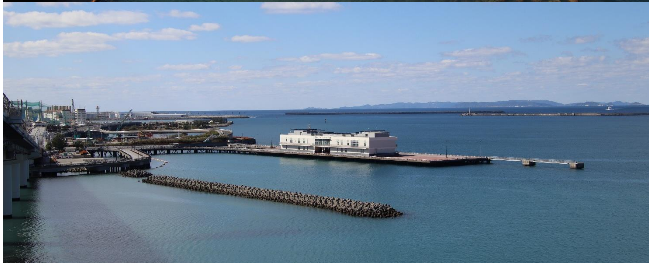
第1クルーズターミナル(泊地区)です。上の写真の画面右の建物の陰に「MSC ベリッシマ」が停泊しており、煙突だけが見えています。この第1クルーズターミナルは市街地にも徒歩圏にあるので、寄港するクルーズ客船には便利なターミナルです。
